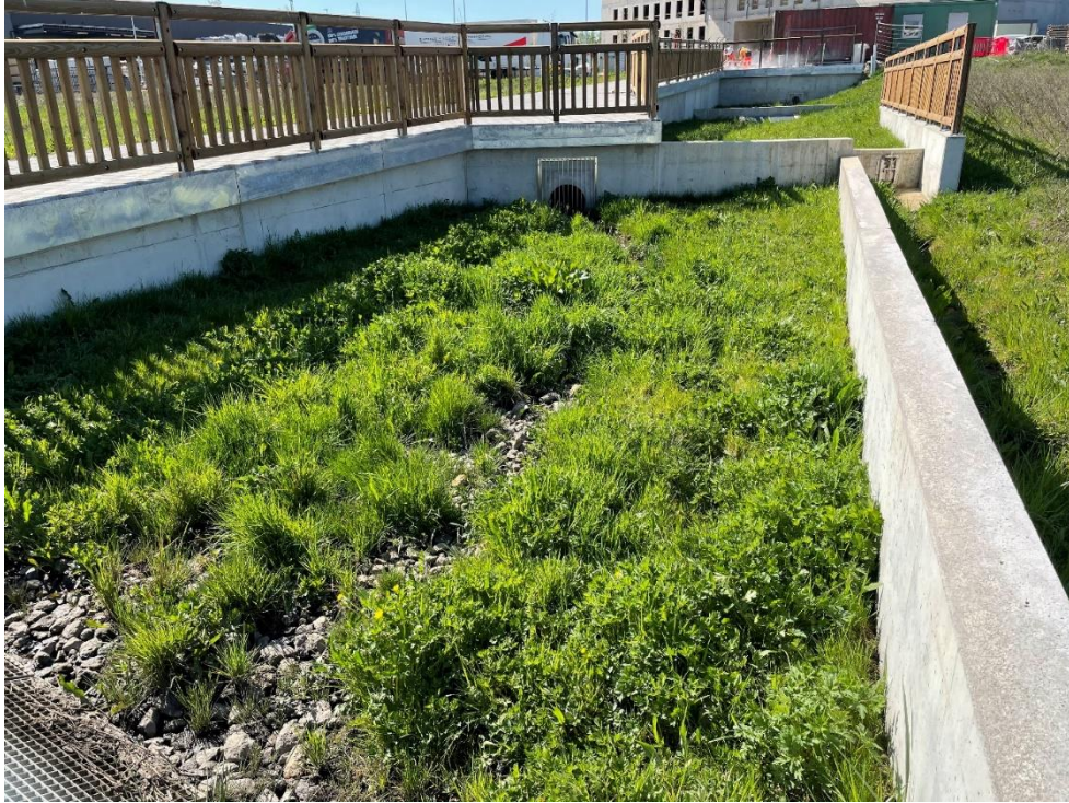
In der Nähe der Gebäude
